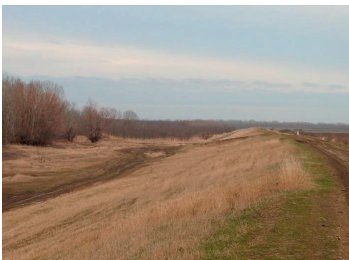
Figure 3. The flood protection dike Nămolosa-Măxineni
